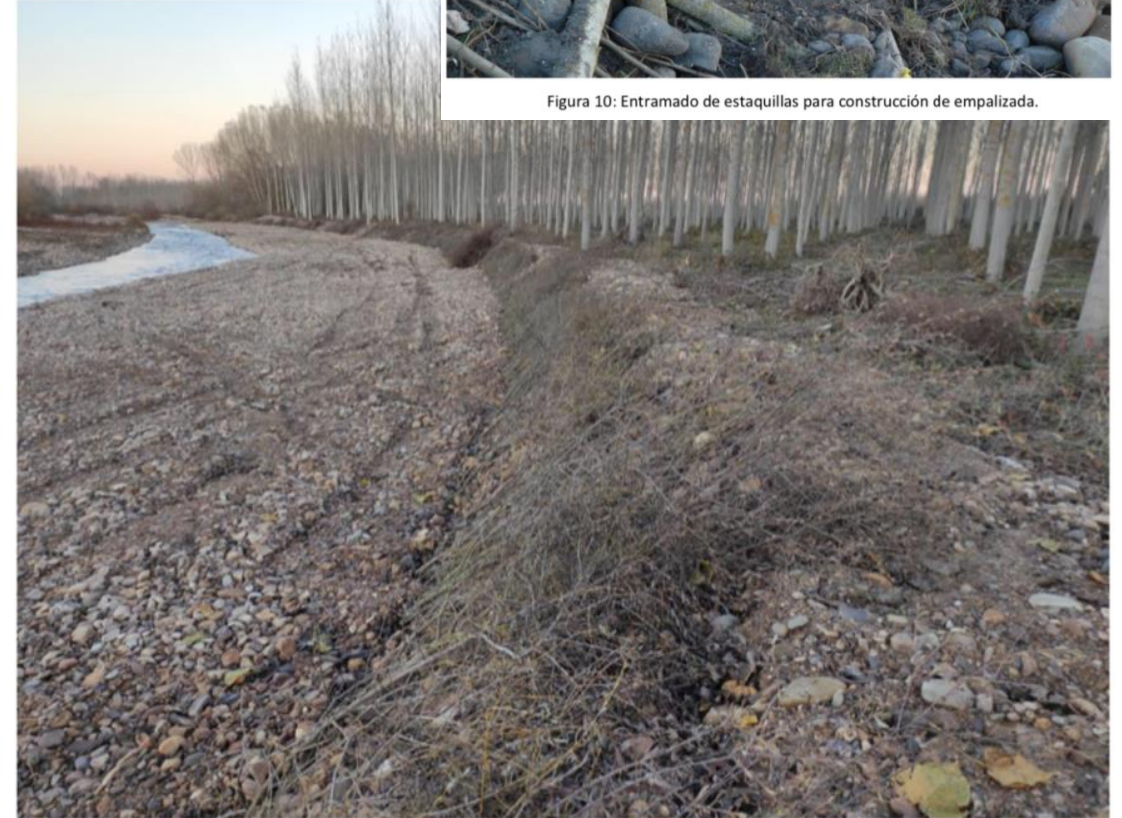
Figura 25: Detalle de empalizada y plantación de estaquillas.
