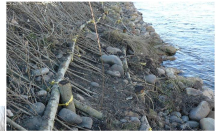
Figura 10: Entramado de estaquillas para construcción de empalizada.
