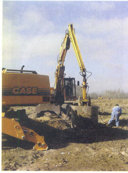
Foto nº6: Extracción de tierra dentro del tubo
