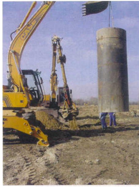
Foto nº2: Retroexcavadora con tubo
