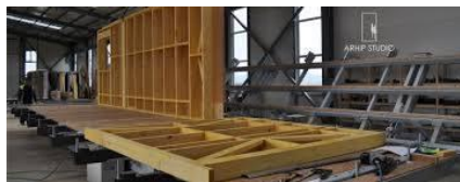
Prefabricación o mecanizados de estructuras
