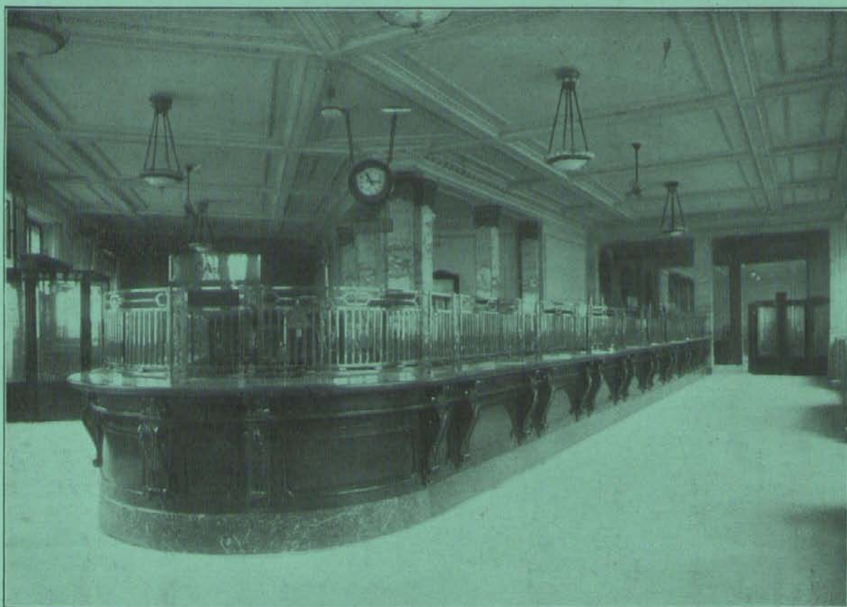
Salón de público del Banco Español de Crédito, construido en mis talleres
