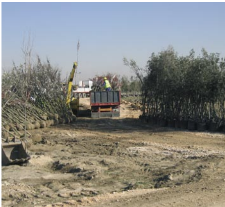
Descarga del camión y acopio de planta de gran porte para plantación en Parque Periurbano
