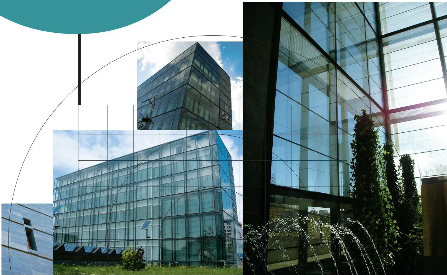
Edificio Sede del Ente Regional de la Energía de Castilla y León
