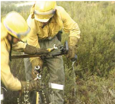
Figuras 83 y 84. Acoplando el nuevo tramo
