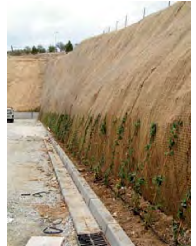
Figura 2. Manta orgánica combinada con un enrejado metálico en un talud del polideportivo de Alhama, Granada.
