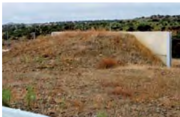
Figura 4. Dispositivo de escape para tejones en una autovía holandesa (arriba) y rampa de escape en un tramo de la provincia de Cáceres en la autovía A-66 (abajo).
