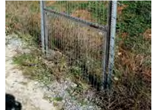
Figura 8. Dispositivos de escape para fauna mal ejecutados como consecuencia de una vigilancia ambiental deficiente o a la que no se le reconoce autoridad. El primer dispositivo estaría constituido por un muro, inexistente, y una rampa de tierra inacabada (Foto: TEG-UAM). El segundo por un portillo abatible que, al estar su base enterrada, no se puede abrir (Foto: Carlos Iglesias).
