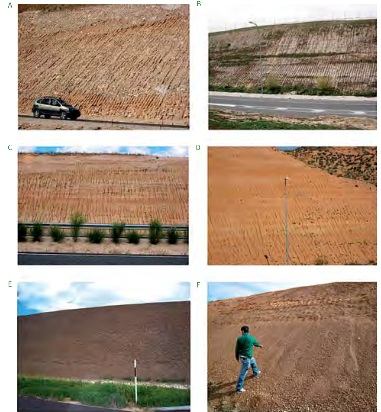
Figura 3. Morfologías que se desarrollan de manera más 'típica' sobre cada una de las litologías detríticas que caracterizan los desmontes de las infraestructuras lineales de la cuenca de Madrid, bajo condiciones climáticas mediterráneas (en Barbero et al. , 2009a) (Fotos: J.F. Martín Duque).
