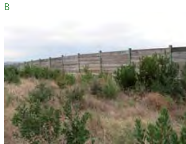
Figura 12. Ecoducto de tipo falso túnel construido en un tramo de la provincia de Cáceres de la autovía A-66 (A). Y detalle de la revegetación realizada en el interior del paso (B).
