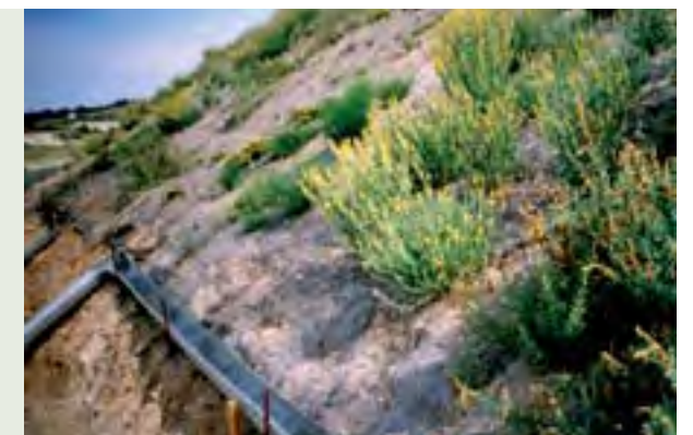
Figura 15. Vista del talud del ejemplo.
