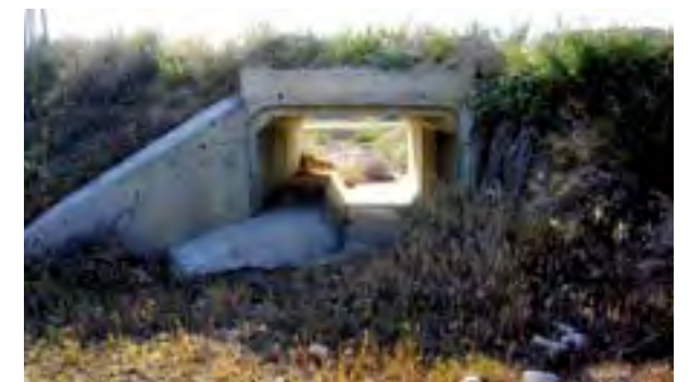
Figura 5. Drenaje adecuado con banquetas laterales (TAV Madrid Barcelona, tramo en la provincia de Guadalajara).
