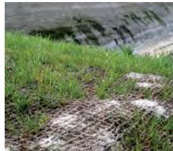
Figura 3. Red orgánica de fibra de coco instalada un tramo de AVE en Humilladero (Málaga). Obsérvese cómo la manta permite la germinación de las especies herbáceas.
