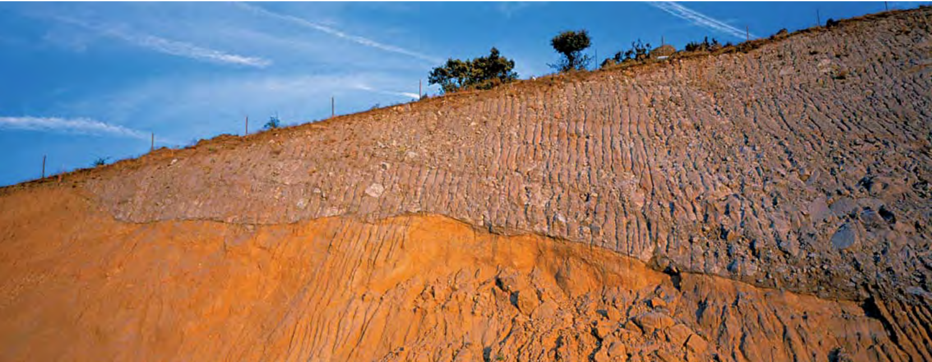
Lugar de interés geológico excepcional (cabalgamiento o falla inversa), expuesto como consecuencia de unas obras de ampliación de la carretera N-110, en el borde norte del Sistema Central (proximidades de la localidad de Villacastín). El material grisáceo situado sobre la línea oblicua (falla) son granitoides del Paleozoico que ‘cabalgan’ sobre los materiales anaranjados y ocreos correspondientes a arenas arcóicas del Cenozoico (Foto: Alberto Carrera). En Díez y Martín Duque (2005).
