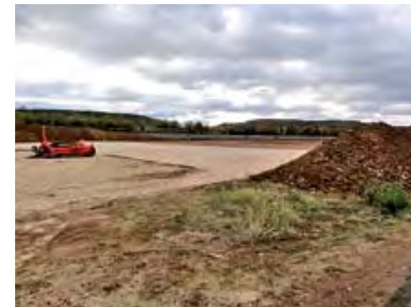
Figura 13. La limpieza final y durante la obra en el entorno de las obras de drenaje es un punto de particular atención del PVA (izquierda). Acopios de tierra vegetal dispuestos en el perímetro de la ocupación de la obra (derecha) (Foto: Carlos Iglesias).
