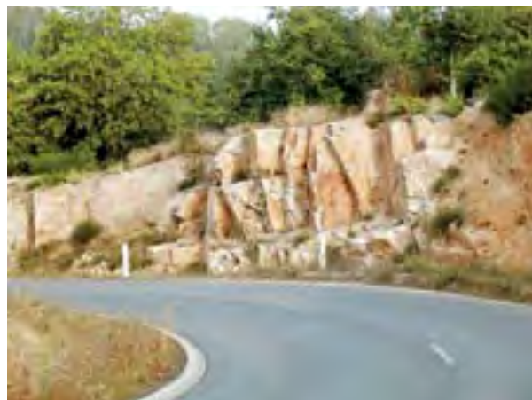
Figura 21. Aspecto de un talud Royal en la carretera RD 105, Loire (Francia), en el que se observa la exposición de superficies ya meteorizadas en un desmonte de reciente construcción (Foto Paul Royal).
