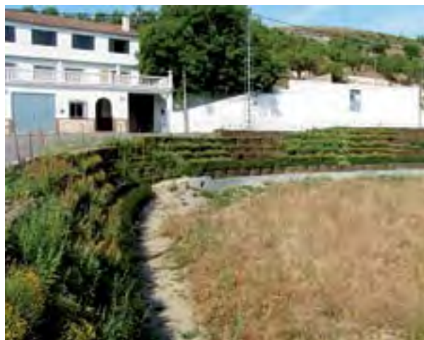
Figura 4. Muro vegetal de acondicionamiento de acceso a Fomes, Granada.
