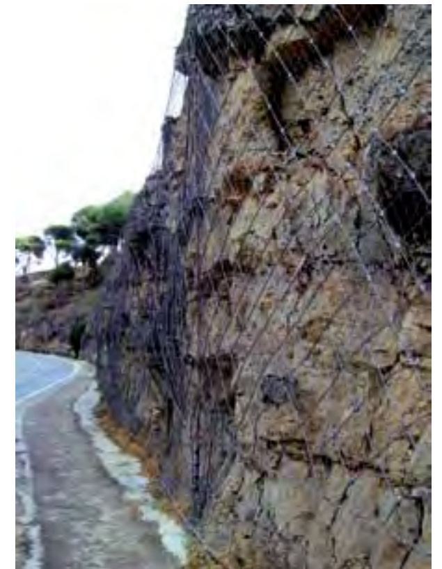
Figura 17. Tratamiento con malla-talud efectuado en la Cuesta de los Hoyos (Segovia) (Foto: Andrés Díez).
