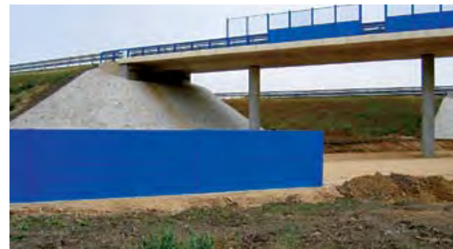
Figura 5. Algunas declaraciones de impacto ambiental establecen la condición de proyectar plantaciones arbóreas para ocultar elementos constructivos como pilares, pantallas acústicas, etc., pese a situarse en una zona donde la legislación vigente prohíbe este tipo de restauraciones (Foto: Carlos Iglesias).
