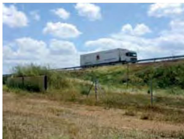
Figura 12. El estudio de la eficacia de algunas medidas correctoras durante la fase de explotación, como los diferentes diseños de dispositivos de escape para la fauna incluidos en estas dos imágenes, serían tareas propias del PS (Foto: Carlos Iglesias).
