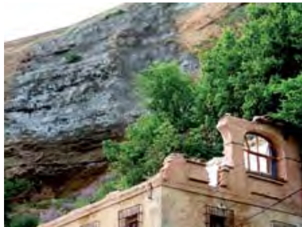
Figura 18. Detalle del bulonado y gunitado elegido como solución técnica para la fijación de la placa de roca contigua a la zona desprendida (Foto: Andrés Díez).
