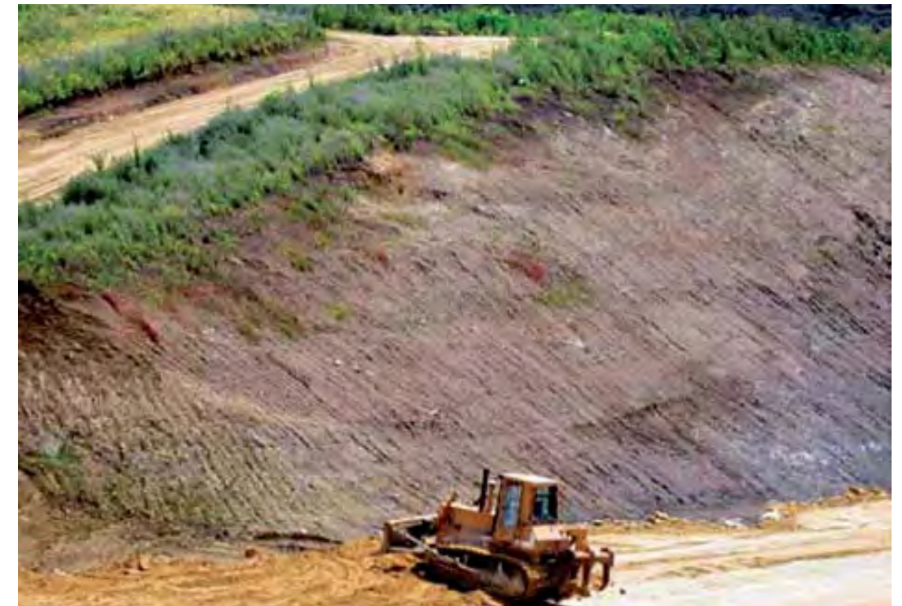
Figura 4. Banda de vegetación favorecida por la presencia de tierra vegetal en la cabecera de un desmonte de la autopista de la Costa del Sol (Málaga) (Foto: Archivo documental del Grupo de Ecología y Fisiología vegetal de Plantas Mediterráneas del IRN-CCMA, CSIC).
