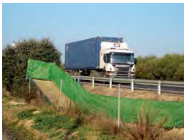
Figura 12. El estudio de la eficacia de algunas medidas correctoras durante la fase de explotación, como los diferentes diseños de dispositivos de escape para la fauna incluidos en estas dos imágenes, serían tareas propias del PS (Foto: Carlos Iglesias).
