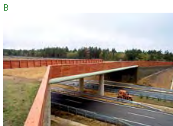
Figura 11. Pasos superiores específicos: paso en forma de diábolo construido en un tramo en la provincia de Palencia en la autovía A-231 (A) y otro paso ubicado en el tramo leonés de la autovía A-66, en el que se pueden observar como los accesos son tendidos para favorecer su uso por la fauna (B).
