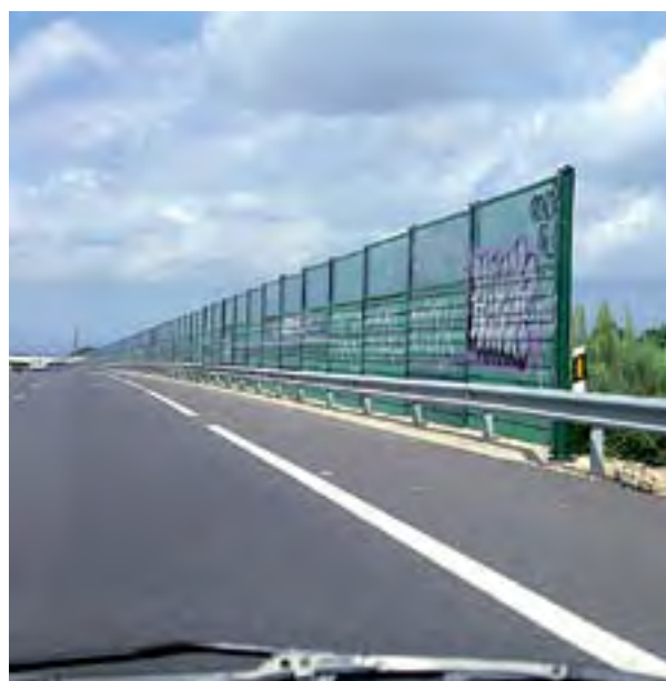
Figura 2. En la imagen superior, típico cartel que anuncia unas obras y pide disculpas a los usuarios por las molestias ocasionadas, durante las mismas que permanece por tiempo indefinido durante la fase de explotación. En la imagen inferior, unas pantallas acústicas, típica medida correctora de impacto ambiental cuya eficacia no podrá ser verificada hasta la puesta en servicio de la infraestructura (Foto: Carlos Iglesias).
