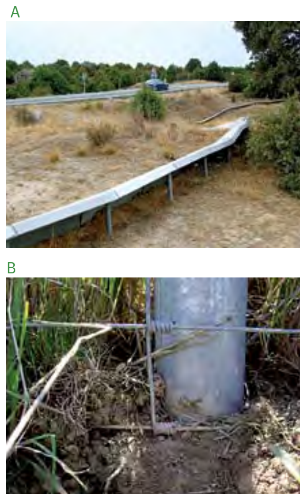
Figura 3. Ejemplos de buenas prácticas en cerramientos: vallado especial para evitar el acceso de anfibios a la calzada (A), ubicado en un tramo conflictivo por el paso estacional de anfibios en la carretera M-618 (Madrid), y detalle de vallado enterrado en la base (B) en la autopista AP-51 en la provincia de Ávila.
