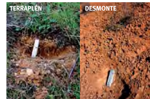
Figura 5. Diferencias en la estructura del suelo de terraplenes y desmontes de la Autovía A-3 a la altura de Requena (Valencia). En los primeros centímetros de profundidad, el nivel de compactación del suelo es mayor en los desmontes. El aporte de materia orgánica al suelo por las plantas (hojarasca y raíces) confiere una mayor estructura al suelo de los terraplenes (Foto: Esther Bochet).
