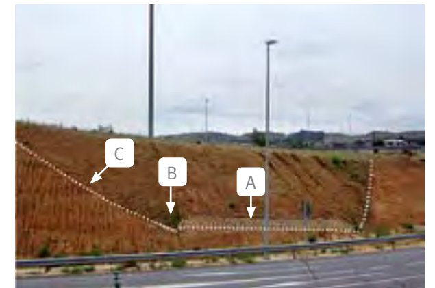
Figura 1. La presión constructiva sobre muchos territorios es tal que, como en el caso que muestra la fotografía, el trazado de una carretera anterior, relleno por materiales de escombrera, puede quedar incorporado, a modo de registro sedimentario, en el desmonte de una carretera más reciente. La línea blanca discontinua señala esta exposición singular. Sobre ella pueden identificarse un corte perpendicular de la plataforma de la carretera, el asfalto (A), las cunetas (B) y los antiguos desmontes (C) (Foto: F. Barbero).
