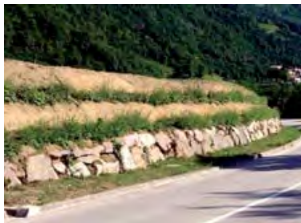
Figura 11. Muro verde de tongadas de suelo introducido en mantas orgánicas con lechos de ramaje entre las tongadas (Meran, Austria; tomado de Florineth 2004).
