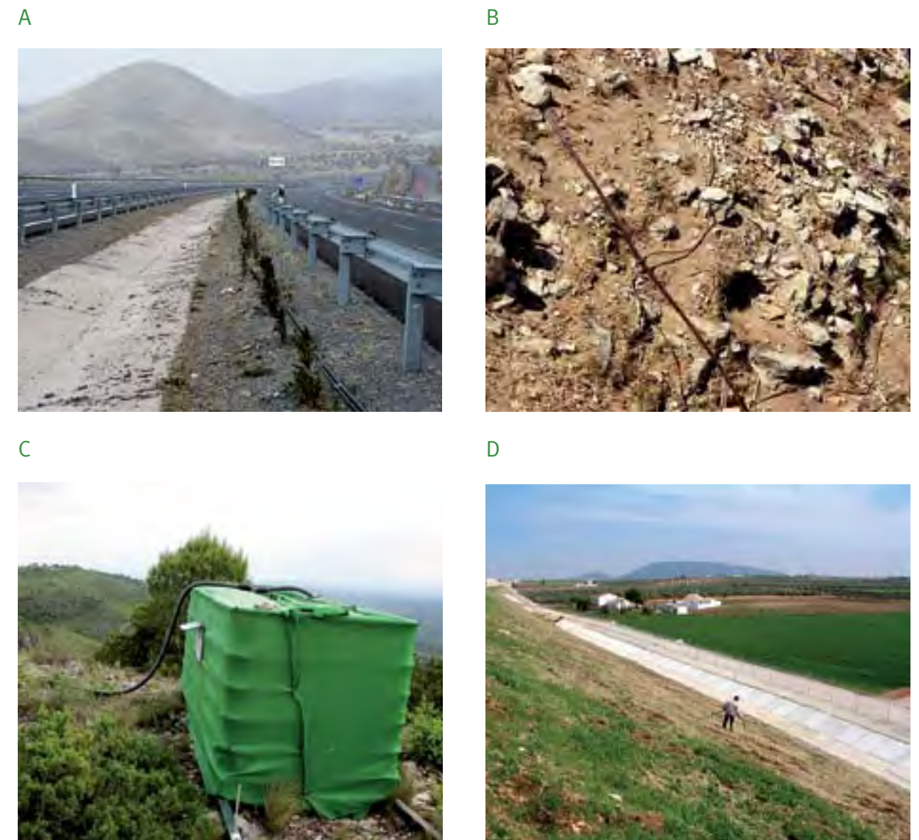
Figura 5. Detalles de tubos de riego por goteo en la mediana de la Autovía A-9 (Almería) (A) y en una ladera plantada de encina en Cazorra (Jaén) (B), una cisterna de agua para alimentar un sistema de riego por goteo en una repoblación en Ayora (Valencia) (C) y regando a mano con manguera conectada a una cuba situada en la parte superior de la infraestructura en un talud del tren de alta velocidad a Málaga (Humilladero) (D) (Fotos: Pedro Villar y Marisa Martínez).
