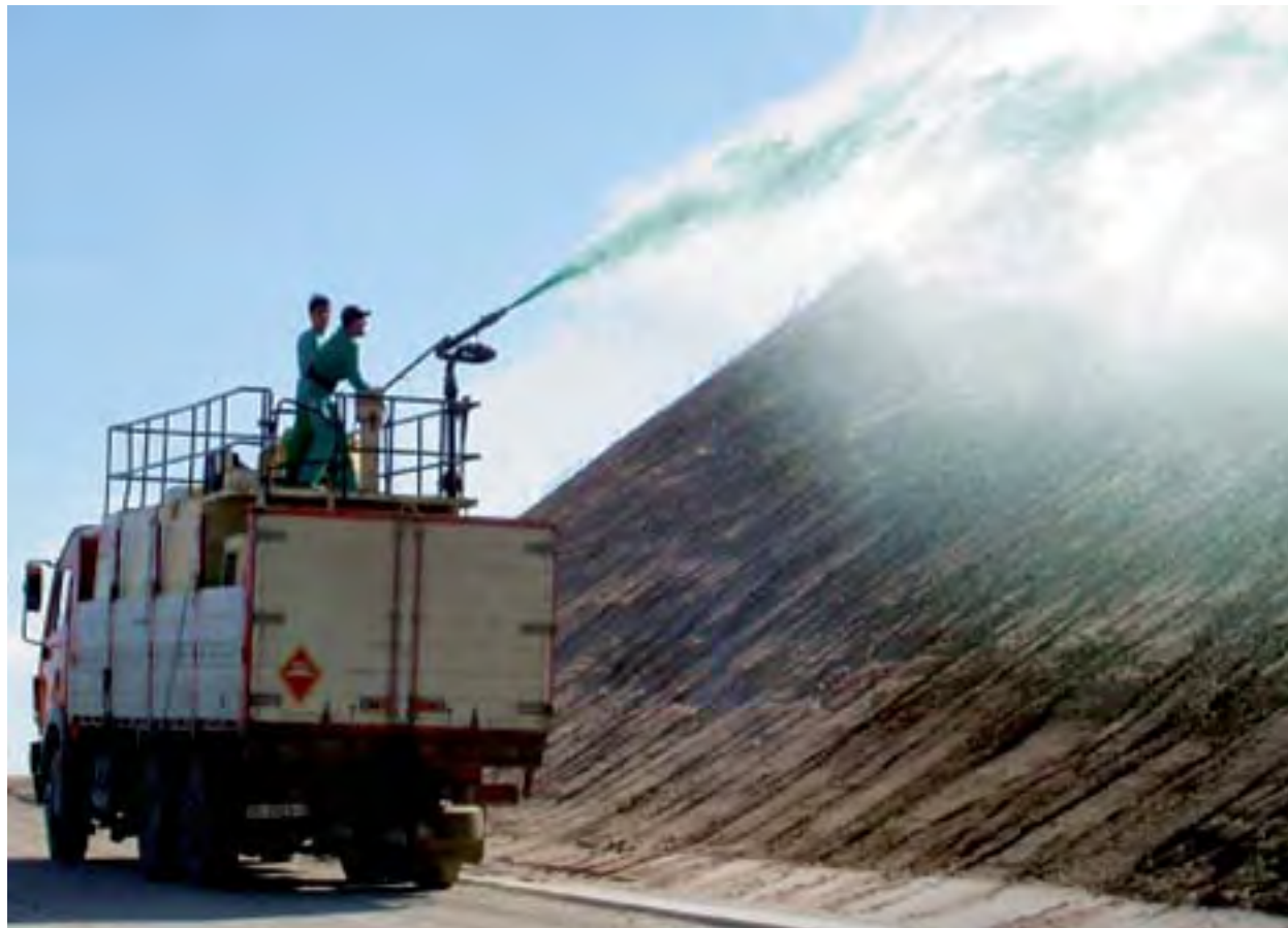
Figura 6. Hidrosiembra de un talud de desmonte desde un camión con moto-bomba. (Foto: María Altamirano-OHL).
