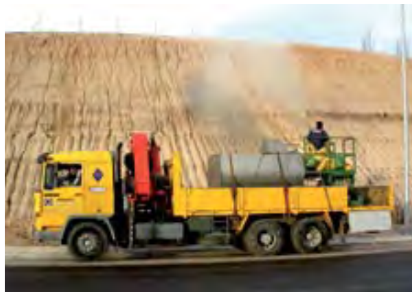
Figura 10. La hidrosiembra es una técnica habitual para sembrar semillas en amplias superficies, como los taludes que se generan al crear vías de transporte. La hidrosebradora consiste en un vehículo equipado con un tanque o cisterna en cuyo interior se mantiene en el cóctel en permanente agitación para asegurar una mezcla homogénea. Los modelos de mayores dimensiones, como el que aparece en la imagen, cuentan con una torreta en la parte superior desde la cual proyectar con una manguera la siembra (Foto: María Altamirano; OHL).
