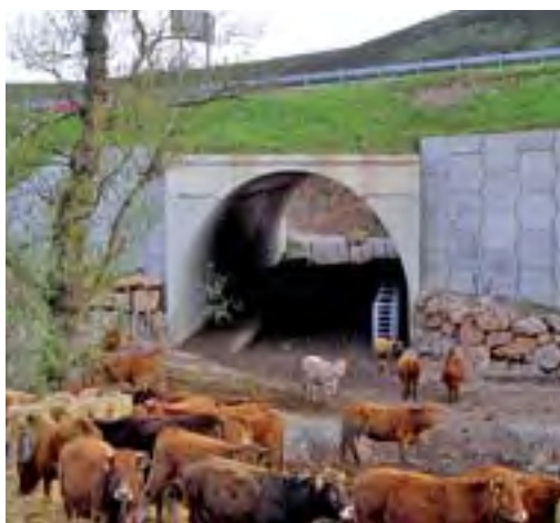
Figura 10. Usos inadecuados que comprometen la efectividad de los pasos inferiores específicos: tránsito de vehículos (A) y aprovechamiento del paso como establo (B).
