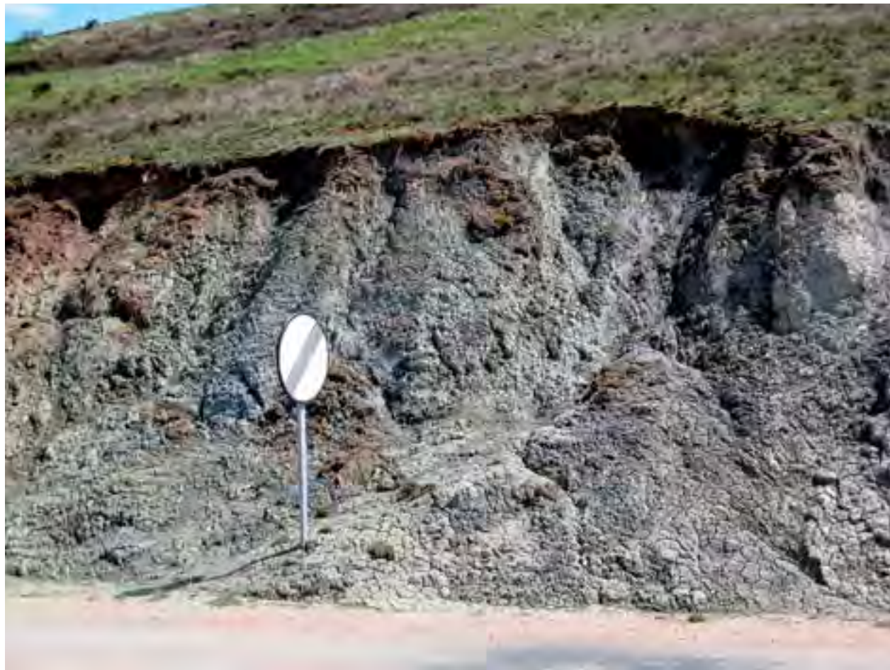
Figura 2. Flujo de barro ( mudflows ) en un pequeño desmonte de una carretera local. Los procesos geomorfológicos que se desarrollan en estos desmontes son similares a los que operan en otros ambientes continentales (por ejemplo, zonas de montaña), pero tienen mucho menor tamaño (Foto: J.F. Martín Duque).
