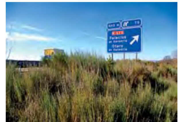
Figura 2. El mantenimiento de vegetación arbustiva en el dominio público permite conectar distintos rodales y pasos de fauna, en la imagen un tramo de la autovía A-52 (Foto: Carlos Iglesias).
