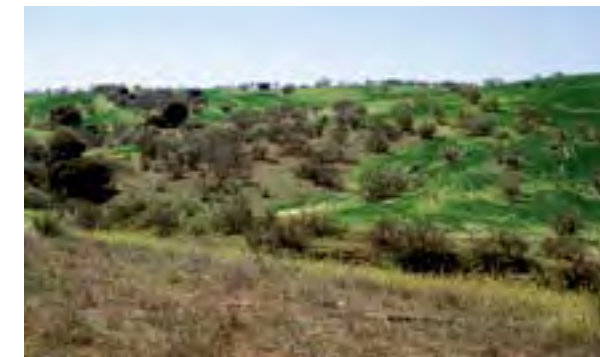
Figura 2. Terraplén con orientación sur de la autopista A-5 en la provincia de Madrid, en la localidad de Arroyomolinos. En la foto se observa en primer término el talud objeto de estudio y en segundo la cercanía a una mancha de vegetación natural consistente en una dehesa de Retama sphaerocarpa (Foto: Pablo García-Palacios).
