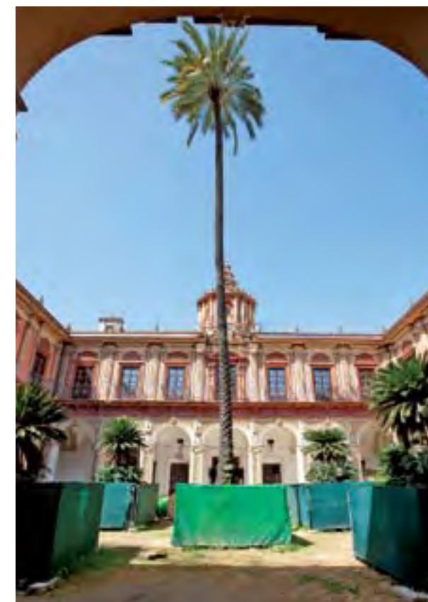
Figura 1. Ejemplos contrapuestos sobre la protección de pies arbóreos en distintas obras. En la imagen superior se ilustra la ausencia de protecciones (Foto: Xavier Artigas) y en la inferior cada ejemplar arbóreo se encuentra protegido por un cerramiento rígido, a su vez recubierto por telas que incrementan su visibilidad.
