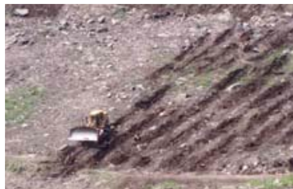
Ilustración 16. Subsólado lineal, mediante bulldozer
