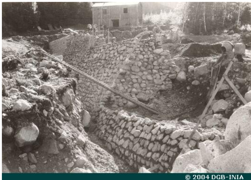
Foto 30: Obras de construcción de un dique en el torrente Remascara, término municipal de Benasque (Huesca) (1964). (Foto: Fototeca Forestal Española DGB- INIA. Sección de Gestión Forestal del Servicio Provincial de Medio Ambiente de Zaragoza. Diputación General de Aragón)
