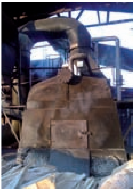
Horno generador de calor para transformación en energía.
